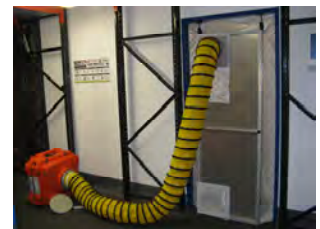
Luftreinigung / Staubschutz, Beispiel Luftreiniger mit HEPA-Filter und Staubschutztür
