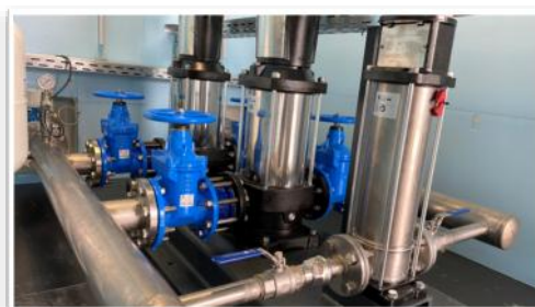
HSHG –System mit mehrstufigen Kreiselpumpen
