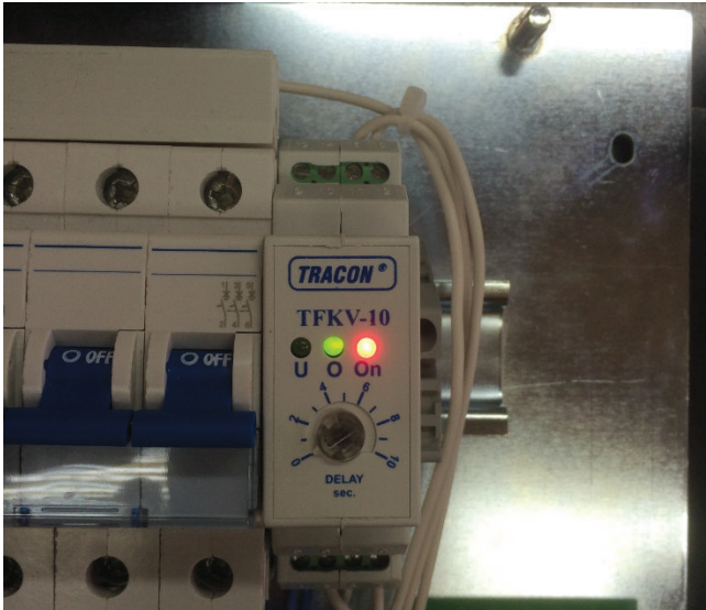
Abbildung 2. Eine oder mehr Phasen fehlen, oder Unterspannung liegt an
